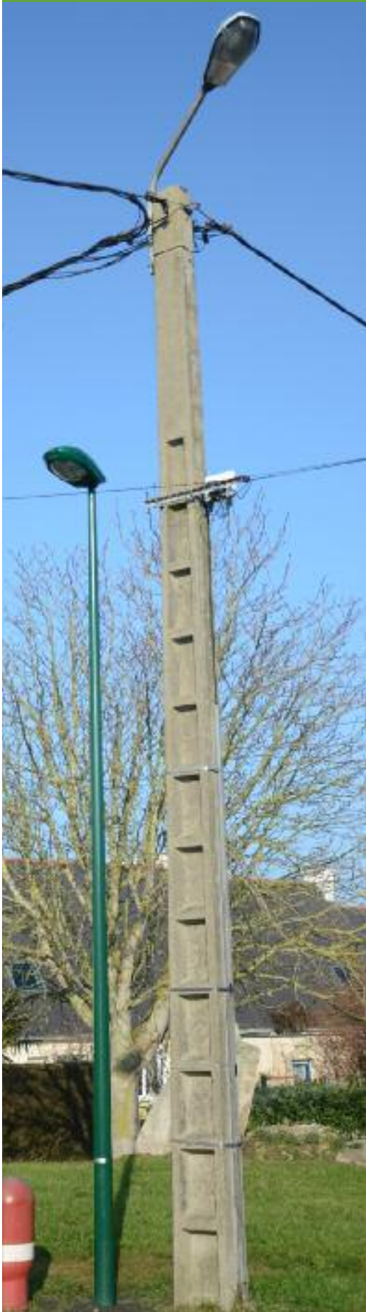
Les nouveaux candélabres ont été posés. Les anciens seront bientôt démontés.
