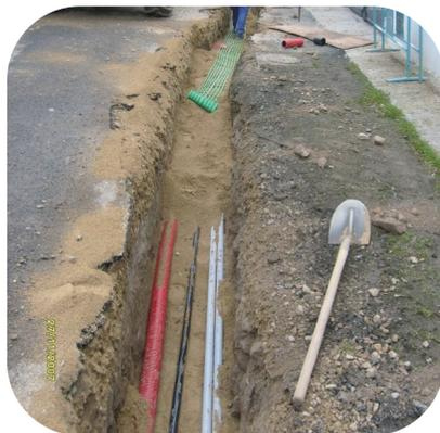
Tranchée commune à l'électrification et aux communications électroniques. Les travaux consistent à créer un réseau souterrain comprenant en général des fourreaux de diamètre 45 mm et des chambres de tirage ou de raccordement. Le réseau ainsi construit est en capacité à recevoir les câbles en cuivre du réseau téléphonique et les câbles optiques du réseau FTTH.
