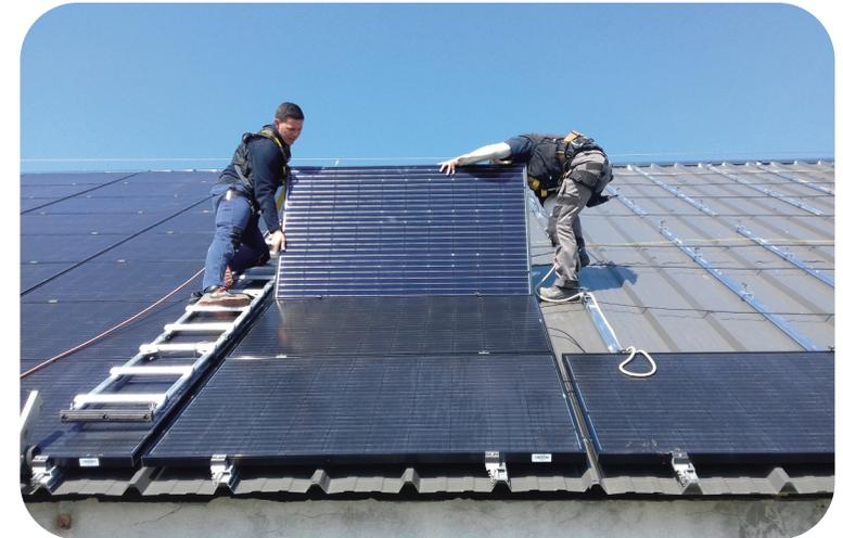
Pose des panneaux photovoltaïques sur l'écloserie de l'île de Sein
