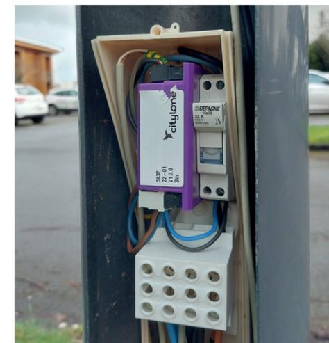
Horloge connectée sur le candélabre qui permet de programmer et contrôler l'éclairage public des communes équipées.
