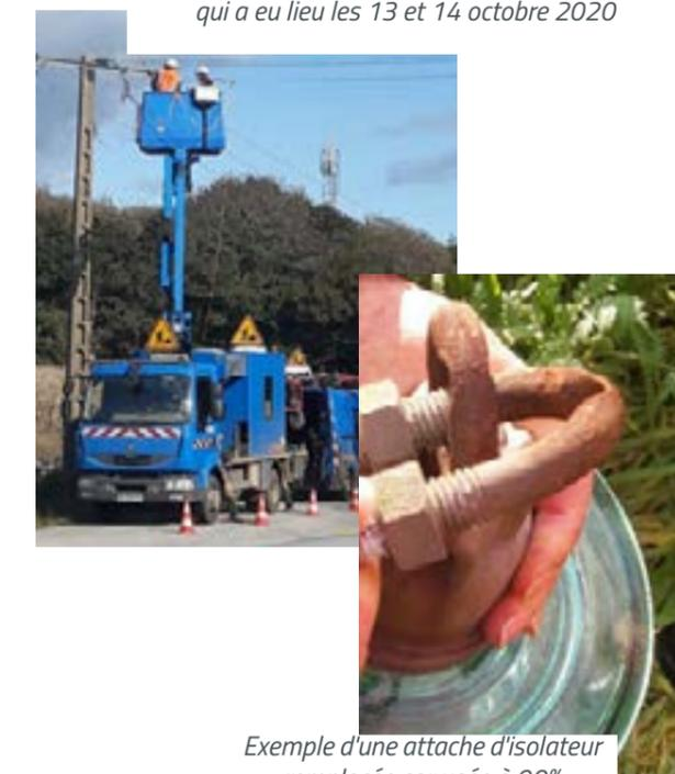
Exemple d'une attache d'isolateur remplacée car usée à 90%
